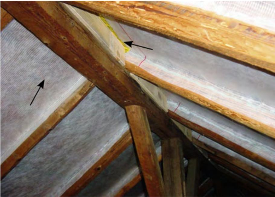
Figure 23: Doublure du lambrissage au moyen d'une bâche et obstruction des fentes des planches. (Photo: BIF/Ch. Brossard)
